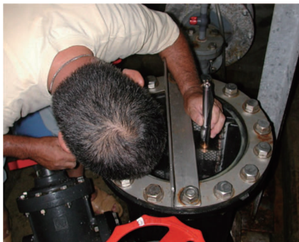
取水ピット内のストレーナー点検（地下12m）
