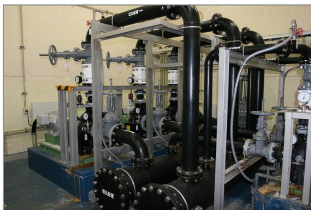
「第二の心臓」送水ポンプ
