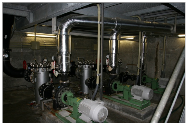
深層水施設の「心臓」取水ポンプ
