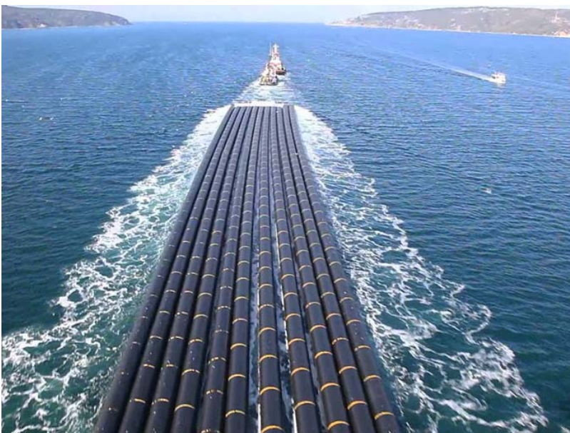
図4 2011年にノルウェーの Pipelife Norge AS 社からウクライナのオデッサまで下水管用の硬質ポリエチレン管（直径2m）を長さ500mの管11本に分けてタグボートで約4週間かけて運んでいる様子。オーシャン・エコパークが必要とする海洋深層水の取水管用の硬質ポリエチレン管も同様の方法でノルウェーからキュラソーまでタグボートで牽引して輸送する計画。（ノルウェーの Pipelife Norge AS 社提供）
