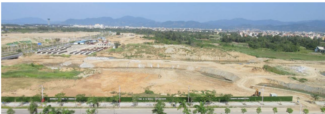
図1. 海南省三亜市郊外で進んでいる新海洋産業都市の建設現場。インキュベーション棟9階から撮影したもので、左手が海。上海交通大学など大学キャンパスは左手前方の林の向こう側。上海交通大学の工事着工は2020年度の手定。
