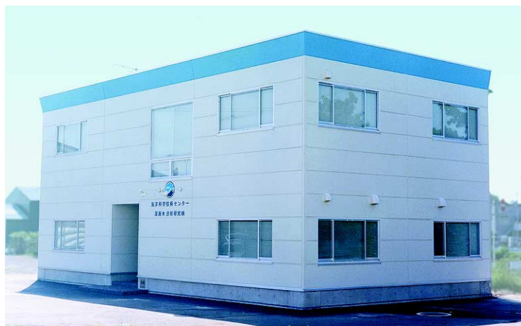
深層水分析研究棟の全景（トピックス（2）参照）
