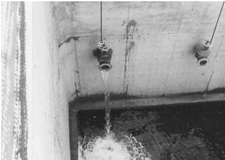
通水試験の様子
