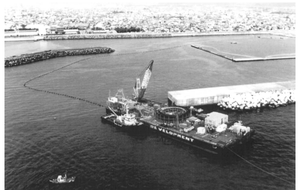
敷設台船による取水管の陸揚げ作業
