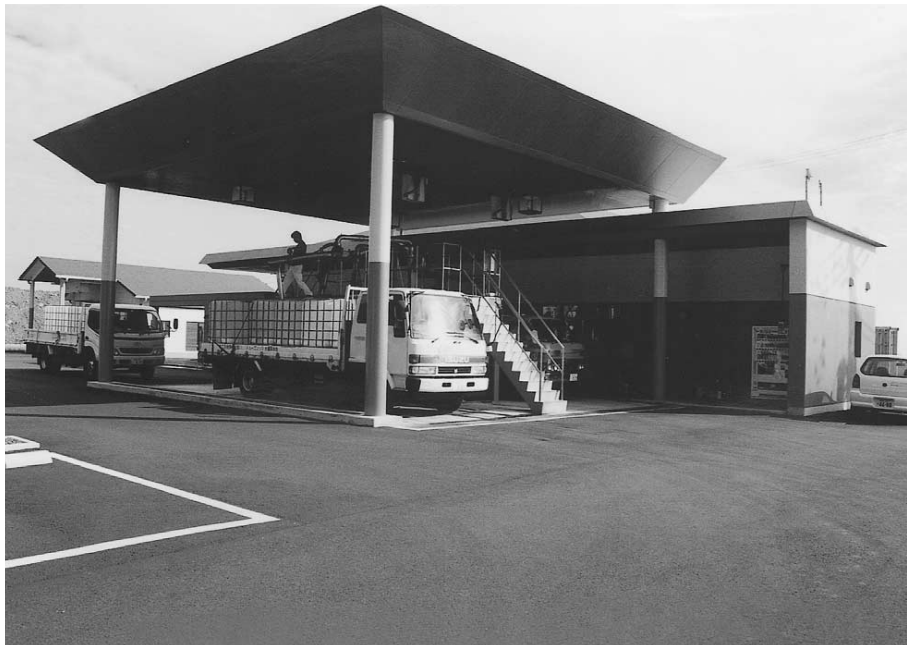
海洋深層水の給水状況
