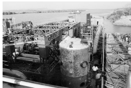
図5. バージ上の配管の状況
