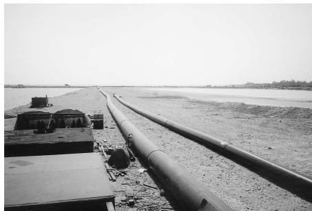
図6. 冷海水取水管
