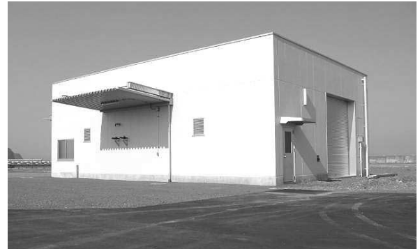
深層水脱塩施設外観
