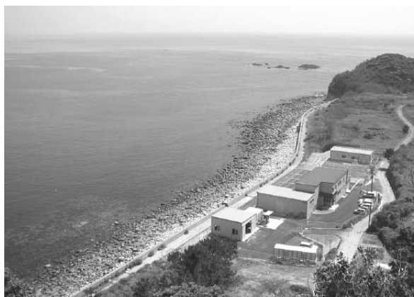
甌島取水施設（こしき海洋深層水株式会社）全景
