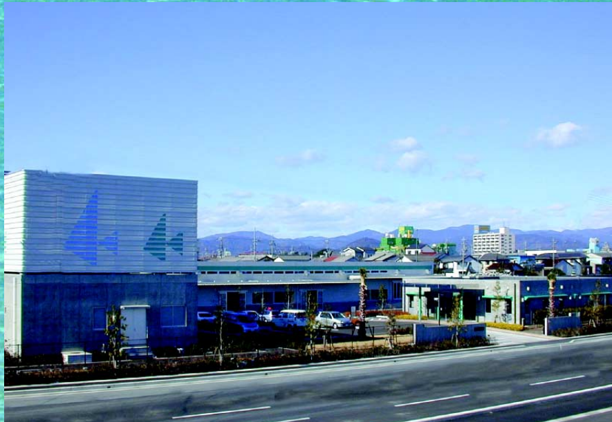
静岡県海洋深層水利用施設（利用施設遠景）
