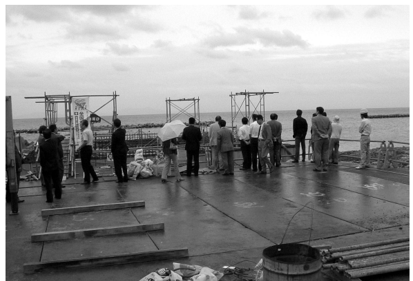
写真4 取水施設工事現場見学
