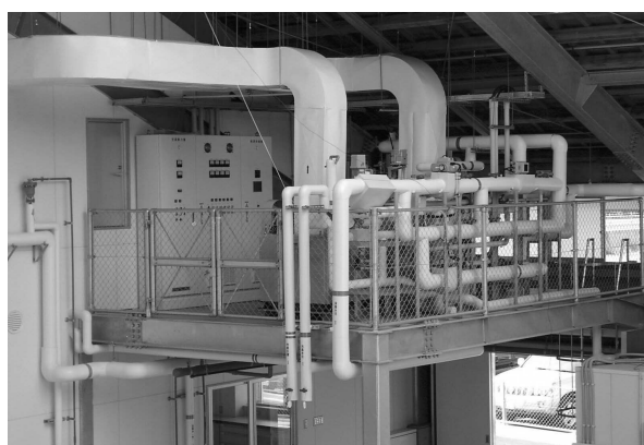
図 1.2 深層水冷熱利用空調システム
