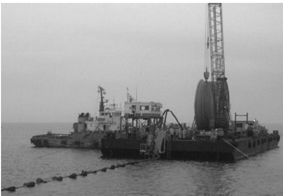
写真2. 敷設専用船による敷設開始状況
