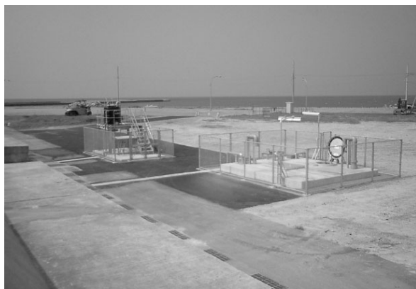
写真1. 取水ピット(手前)と給水口(奥)
