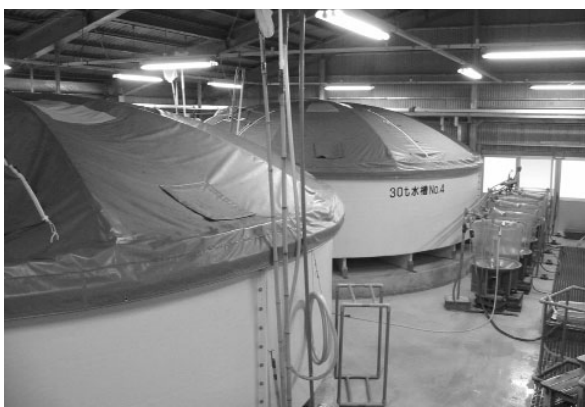
写真2. 支所飼育棟内に配置された親魚槽(30t)及び卵分離槽
