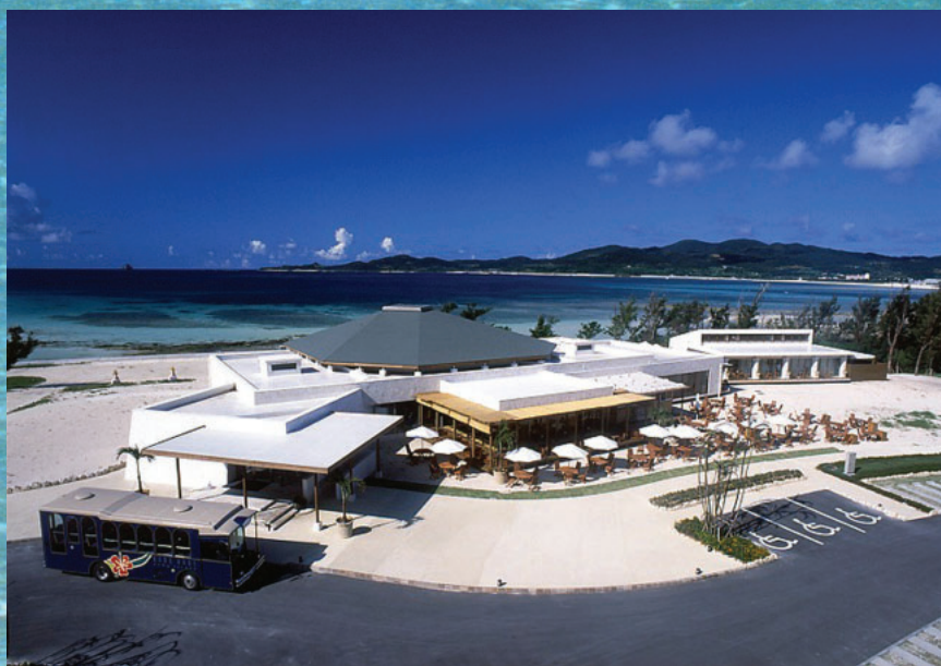
海洋深層水温浴施設「パーデハウス久米島」 (特集(1)参照)
