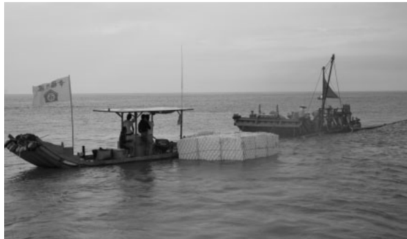
図1. 台湾花蓮縣新城で行われた海洋深層水取水管設置作業の様子 ((財団法人)工業技術研究院提供)
