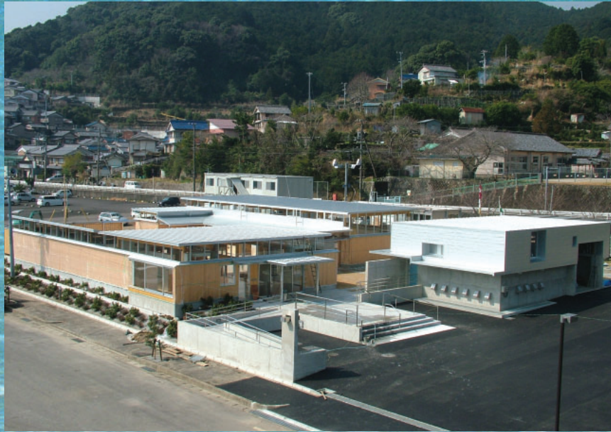
みえ尾鷲海洋深層水取水施設 (トピックス参照)
