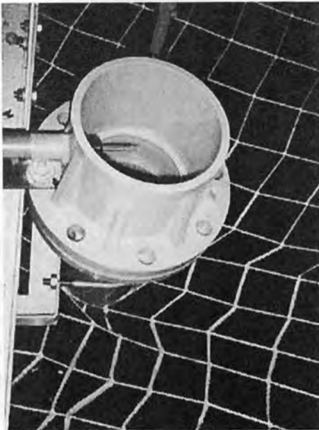
写真-3 揚水管出口部
