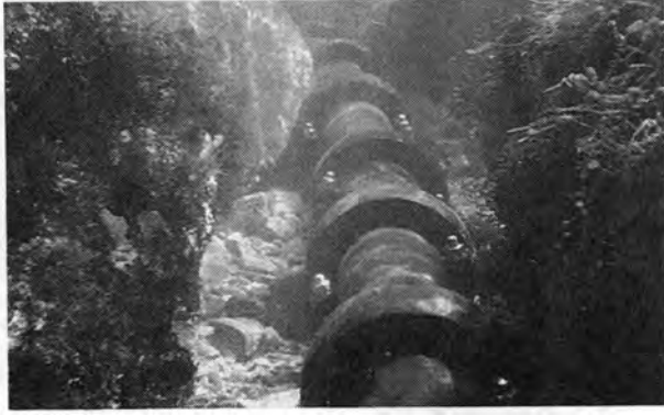
写真-3 防護管施工例
