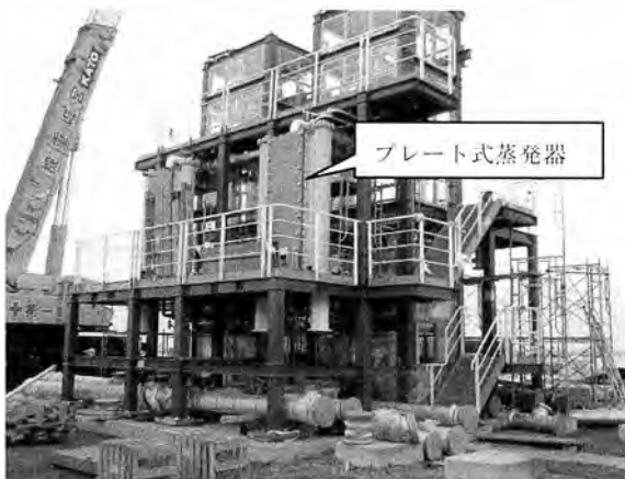
図6 蒸発器の設置
