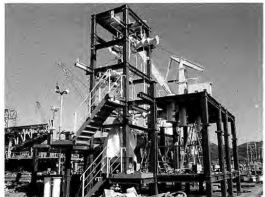
図3 工場での発電ユニット組立て
