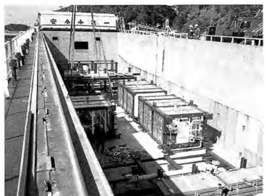
図4 発電ユニットの船への積込み
