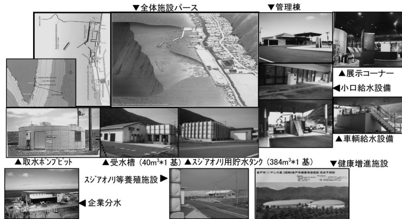
図2-7 室戸海洋深層水アクア・ファームの分水施設概要 (室戸市提供)
