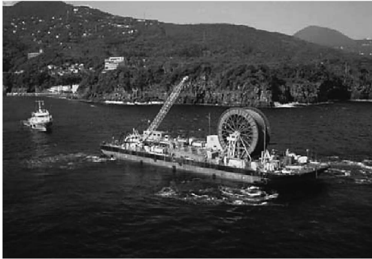
写真1 (上) 取水管の一例 (下) 海洋深層水取水管敷設状況
