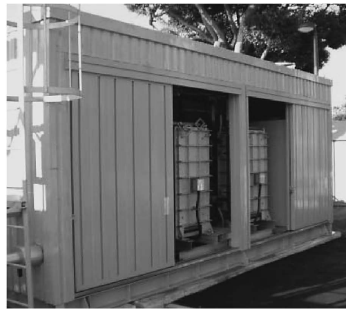
写真2 脱塩プラント (上) イオン交換膜 (ED膜) (下) 逆浸透膜 (RO膜)
