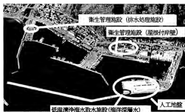
図 2 環境・衛生管理施設を整備する羅臼漁港
